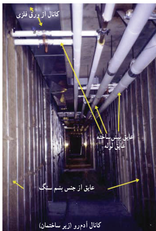
شکل ۲۲-۲- عایق کاری
